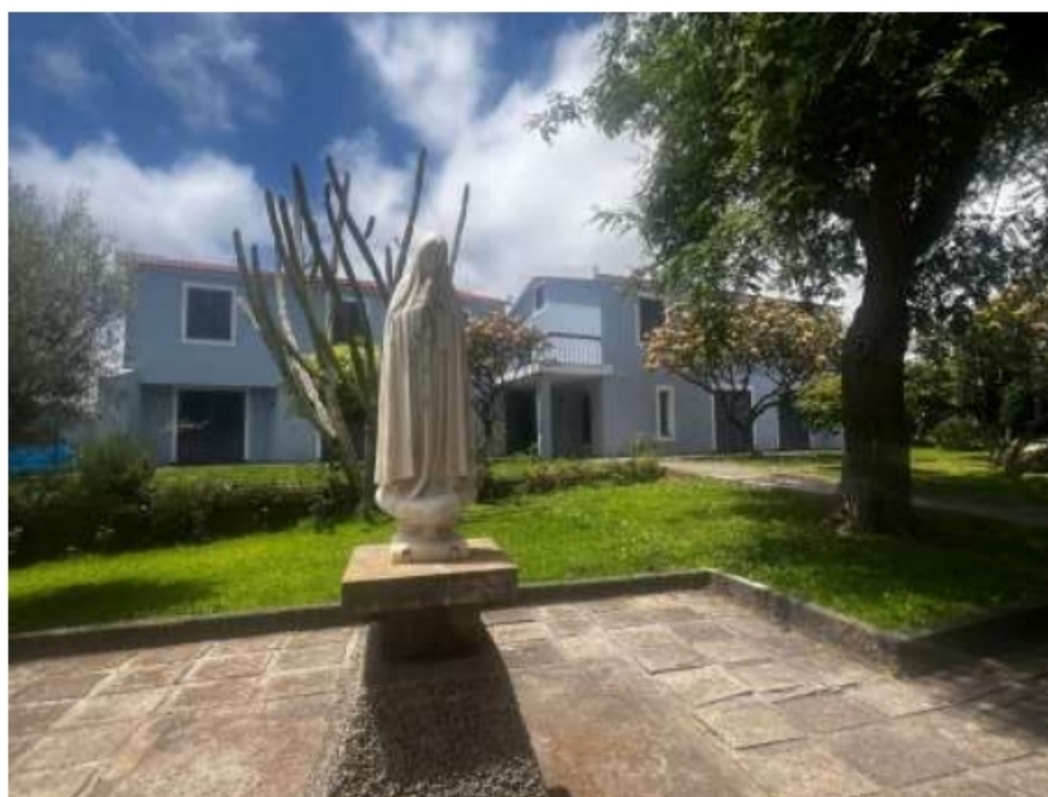
Figura 2 – Vista geral das residências do ANSF.
